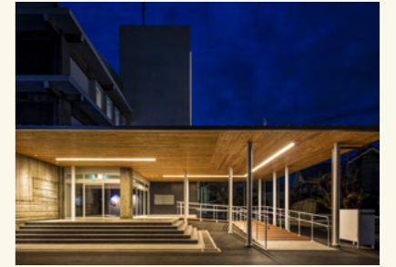
つるぎ町役場本庁舎
